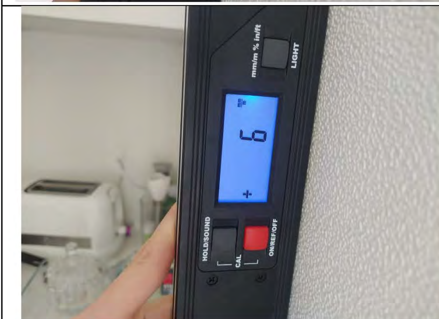
Фото №11. Измерение уровня стен в кухне.
