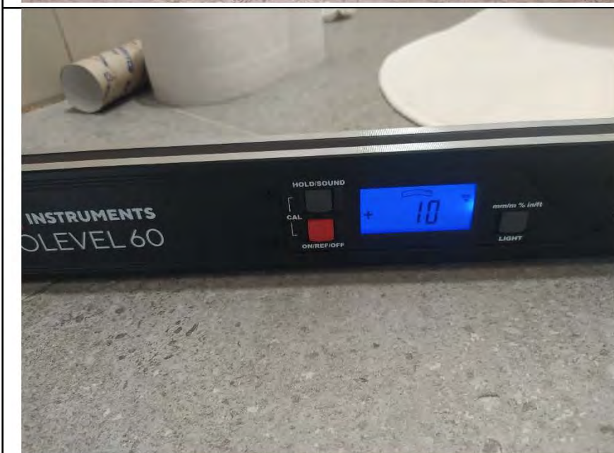
Фото №23. Измерение уровня напольного покрытия в санузле (керамическая плитка).
