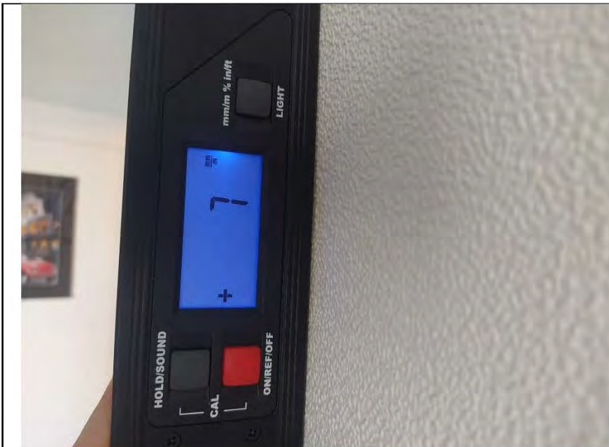
Фото №10. Измерение уровня стен в спальне.
