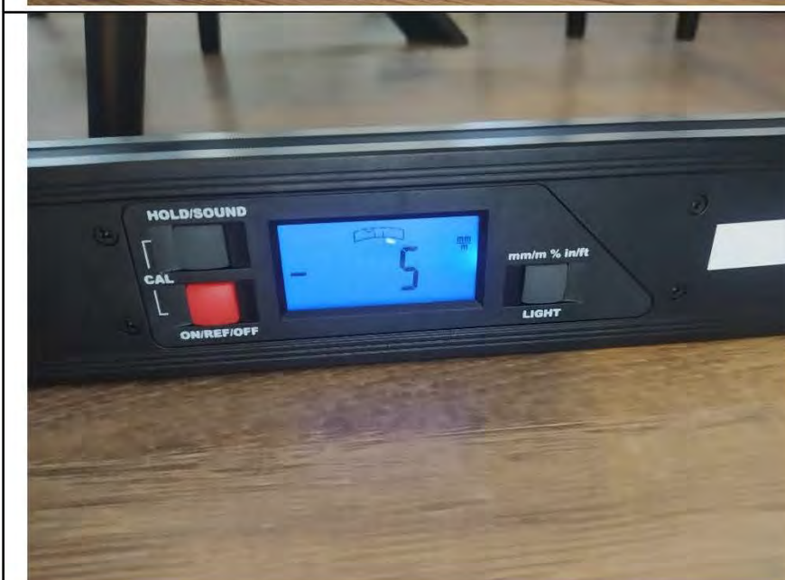
Фото №21. Измерение уровня напольного покрытия в кухне.
