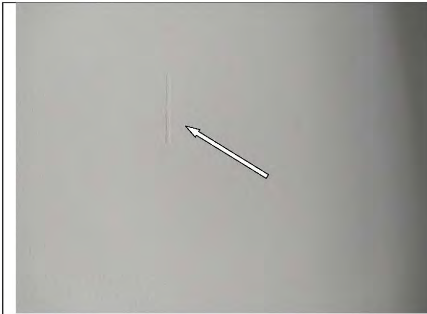
Фото №25. Окрашенные откосы оконного блока ПВХ в кухне выполнены с дефектами (раковины).
