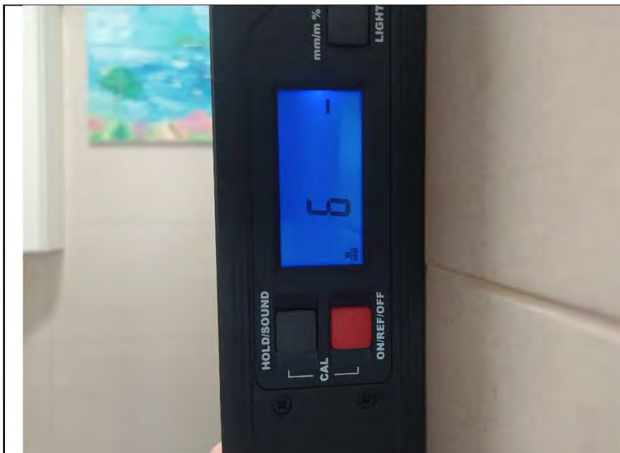
Фото №16. Измерение уровня стен в санузле.
