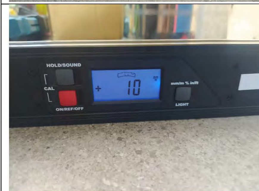
Фото №24. Измерение уровня напольного покрытия на балконе (керамическая плитка).
